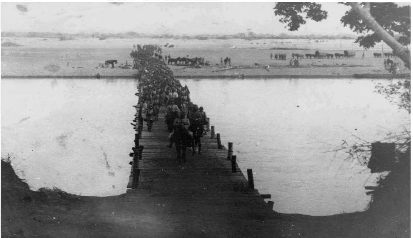
Ponte de cavaletes sobre o rio Rovuma, construída pelas forças portuguesas no norte de Moçambique.
