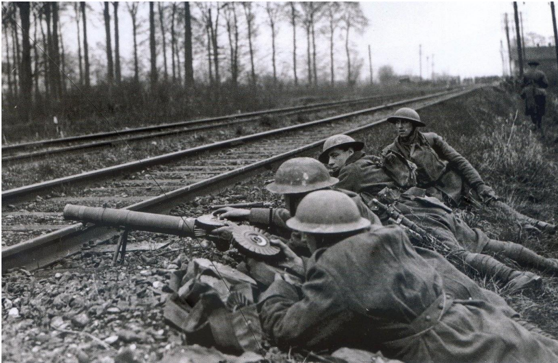
Uma típica Lewis britânica, com uma guarnição de dois homens, um dos quais carregava os tambores da munição. Foi a primeira metralhadora ligeira prática, amplamente usada por quase todos os Aliados, inclusive Portugal.
